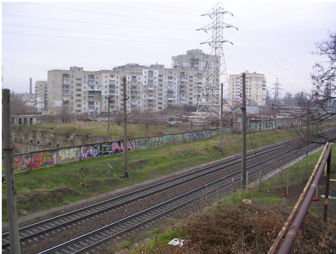
Фото 1. Территория квартала со стороны железнодорожного пути и ул. М. Грушевского.
