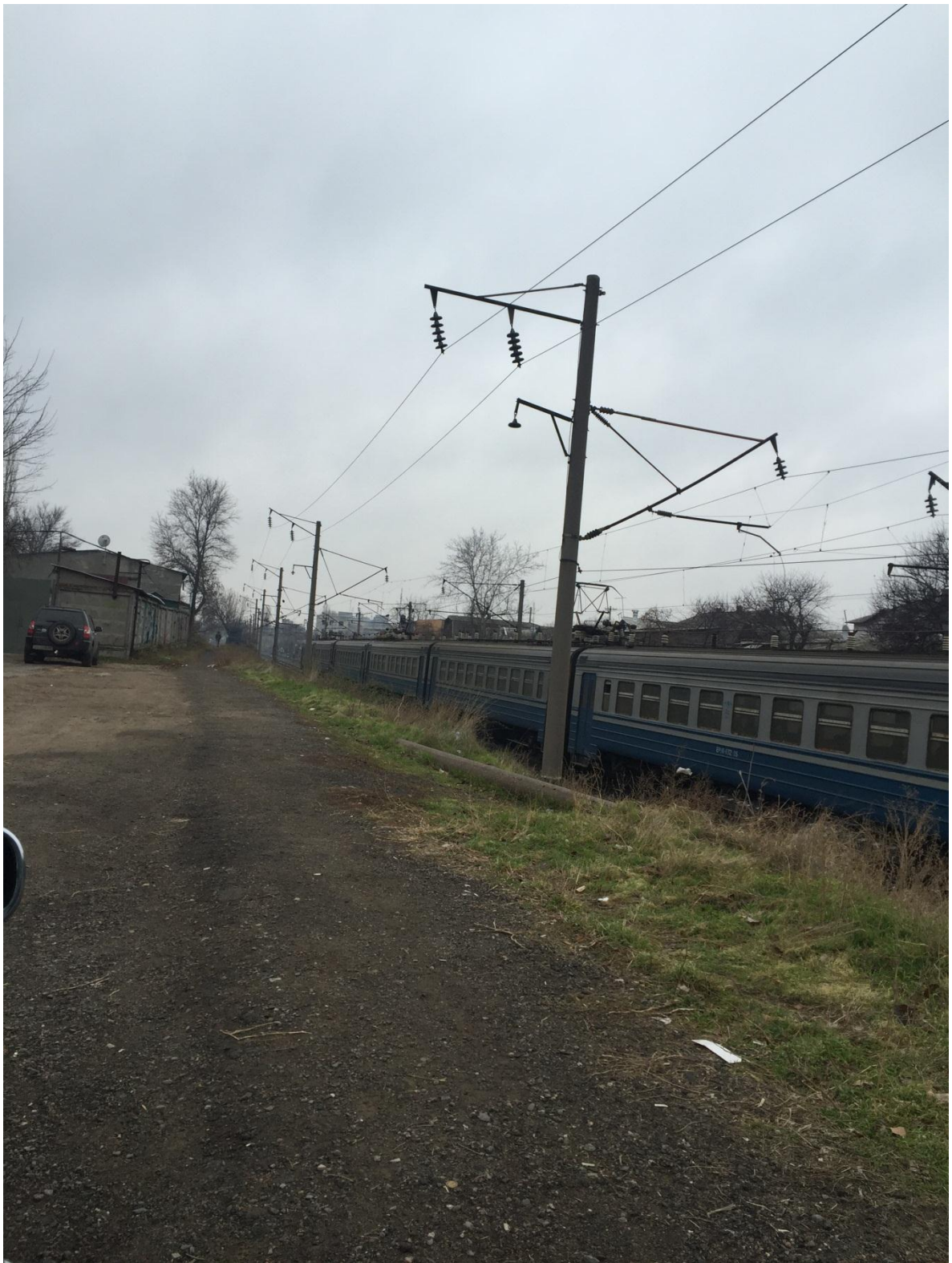
Фото 16. Территория вдоль железнодорожного пути.
